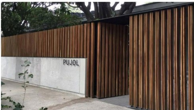
Vallado a vía pública con muro de hormigón armado con coronación de celosía vertical. De acero con pintura corten.
